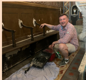
Réhabilitation du cœur de la chapelle NDS
